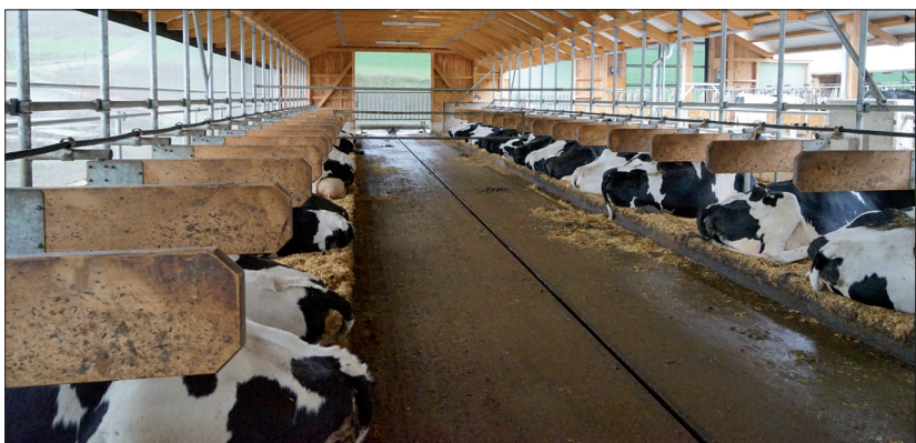
Bequeme Tiefliegeboxen, breite rutschfeste Laufgänge und viel frische Luft sind die Hauptaugenmerke des neuen Stalls in Osweiler.
