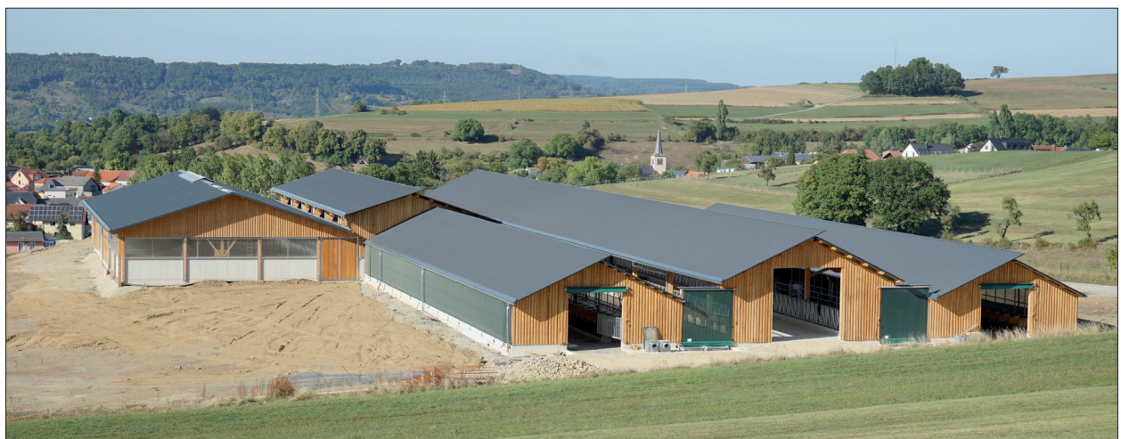
Rund 300 Meter außerhalb des Dorfes liegt das mehrgeschoßige Stallgebäude mit einem zentralen Futtertisch und großzügigem Melkhaus.
